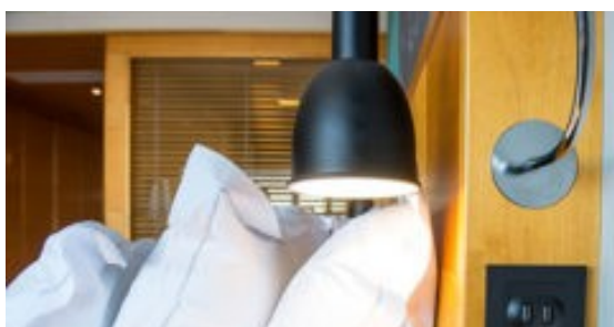
2013 byttes 200 sängarmaturer ut till en mer energisnål variant av Best Lite-lampa. 2015 blev varje säng med 6 kuddar istället för 4.
